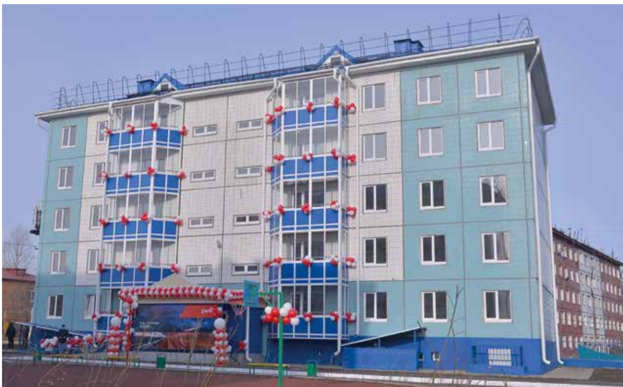
Жители Тулуна уже получили ключи от новых квартир в домах, которые построило ОАО «РЖД»
