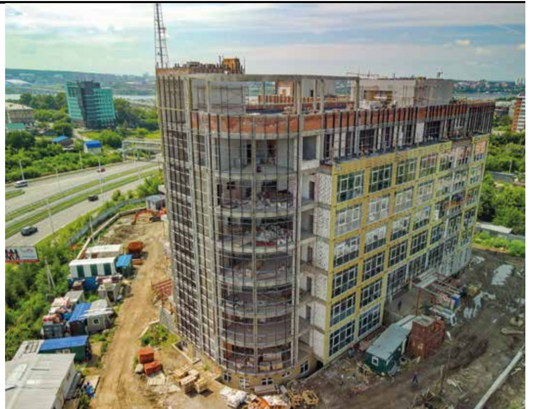
Строительство здания арбитражного суда в Иркутске
