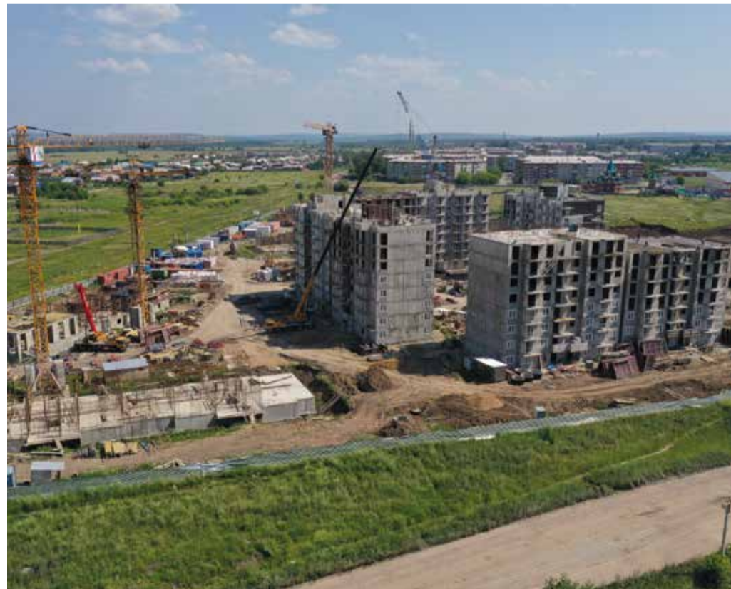
Строящиеся жилые дома, г. Тайшет
