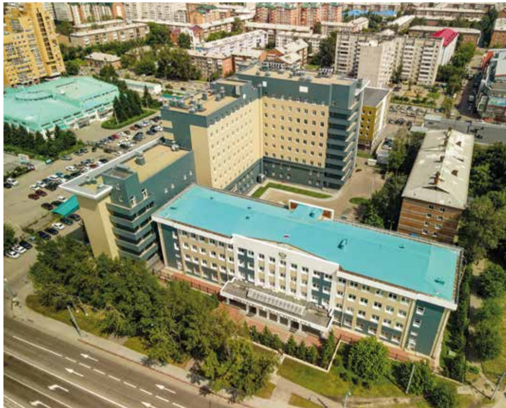
Здание Областного суда, г. Иркутск
